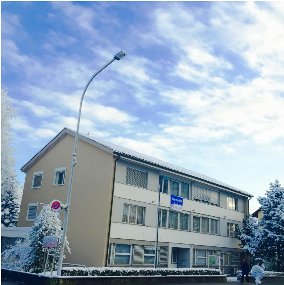
Verwaltungsgebäude Bernstrasse 65d
