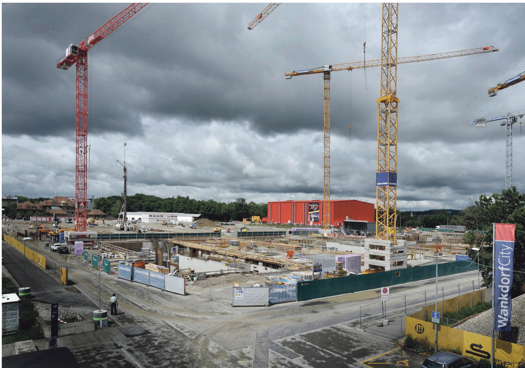
Trotz sinkender Mietpreise hält der Büro-Boom in der Stadt Bern an: Baustelle der Bürostadt Wankdorf-City, die ab 2014 bezogen wird. Foto: Adrian Moser
